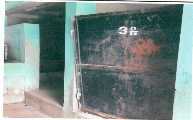
Foto 2: MEJORAMIENTO DE SERVICIOS SANITARIOS Y SUS ACCESORIOS
