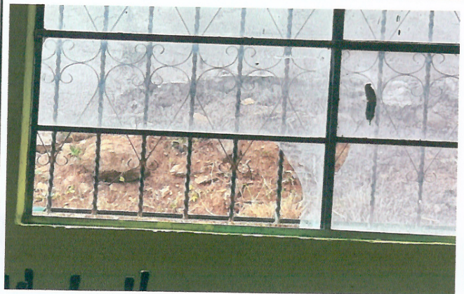
Foto 4: MEJORAMIENTO DE VENTANAS
