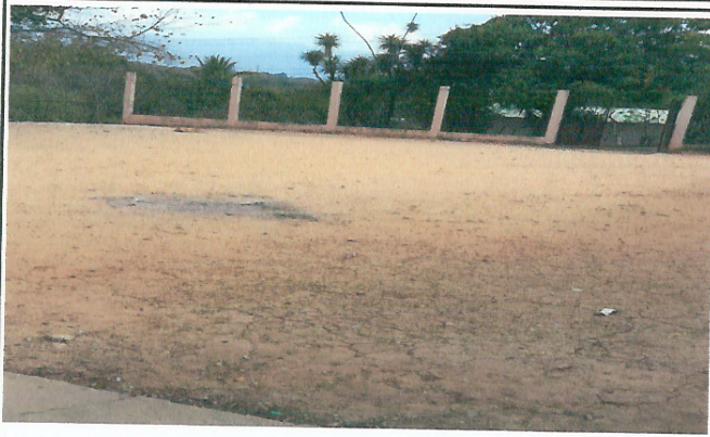
Foto 1: MEJORAMIENTO DE LOSA DE PATIO
